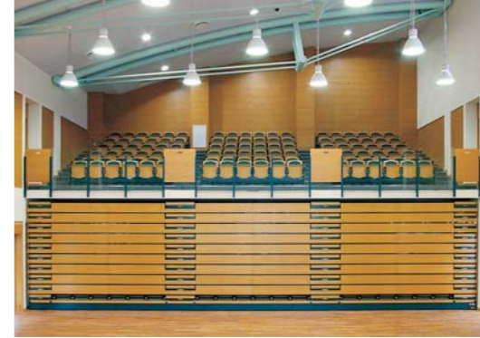
移動観覧席を収納した状態。壁内収納された観覧席の上部には固定の観覧席を設置。空間の有効活用や、席数と上部へのアプローチを確保。
