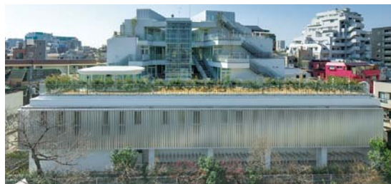
外観写真撮影: 小林研二写真事務所
