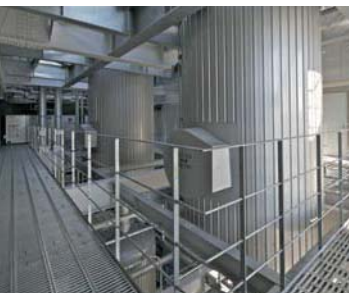
連結縦型蓄熱槽／ヒートポンプを利用した省エネ最先端の巨大蓄熱システム。建物の架構に組み込まれ、廊下などからも見ることができる。
